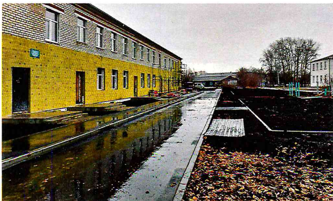
Ремонт ранее перепрофилированного здания детского дома.
